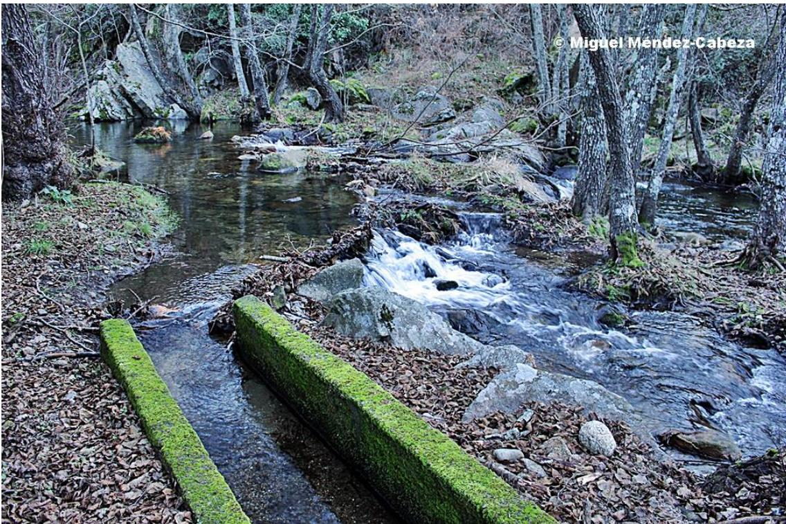
La alimentación del caudal de las acequias se realiza principalmente mediante azudes, pequeñas retenciones de agua, que derivan parte del cauce a estas.
