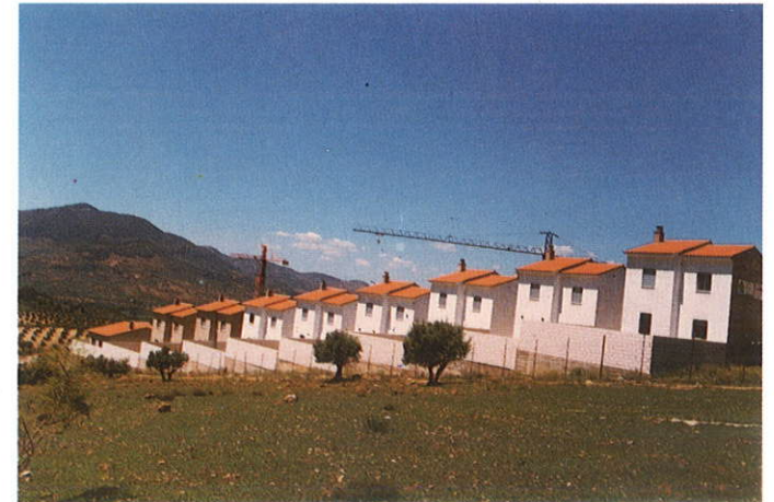
Construcción de viviendas de Protección Oficial «Loma del Convento». Foto: Santiago González.
