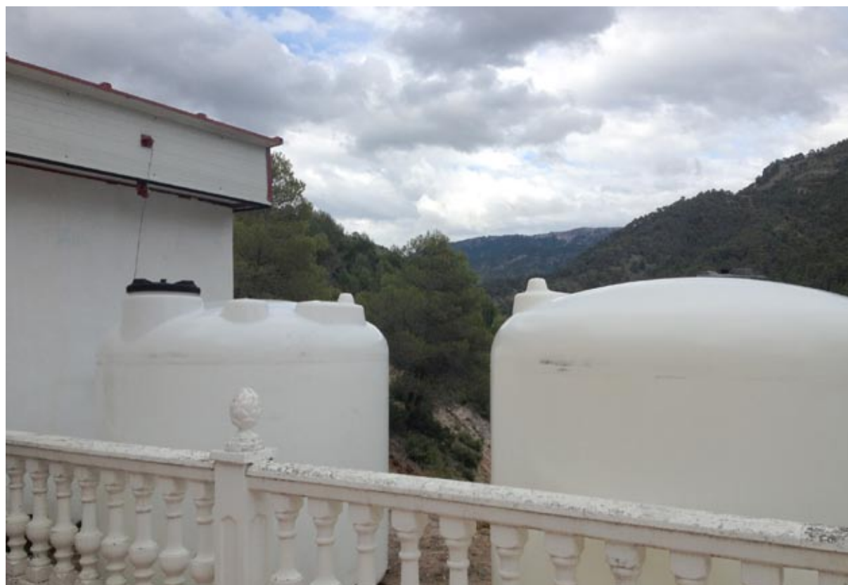
Obras de mejora en la residencia.
