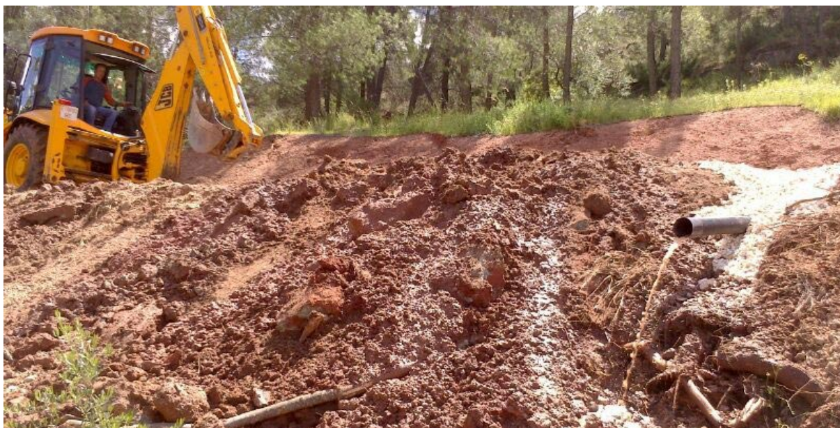
Reparación camino de la Veintena.
