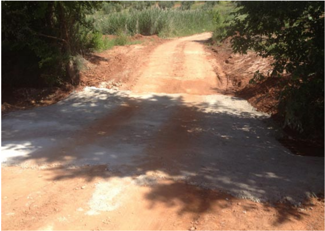
Reparación carril Cañada Ballesteros.
