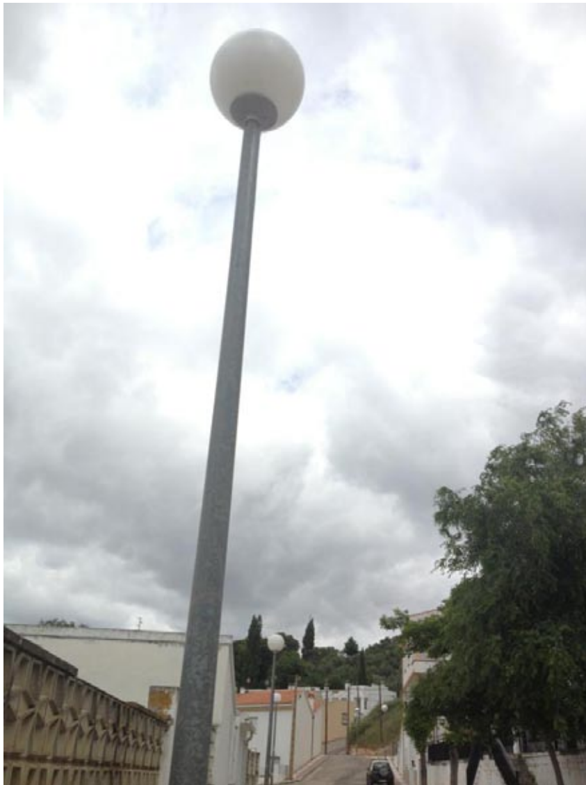
Mejora del alumbrado público en la calle Antonio Machado.
