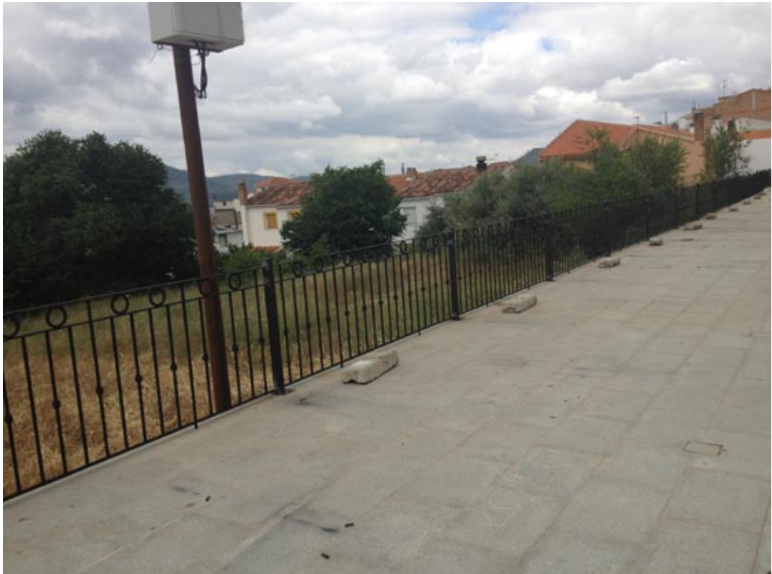
Instalación de la baranda en el Paseo de Ramuña.
