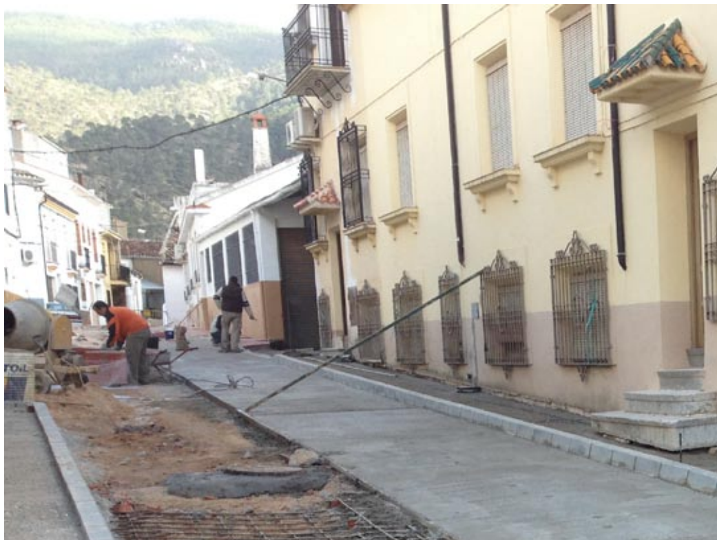
Ejecución de la calle Milagros, dentro del Plan Provincial 2012.
